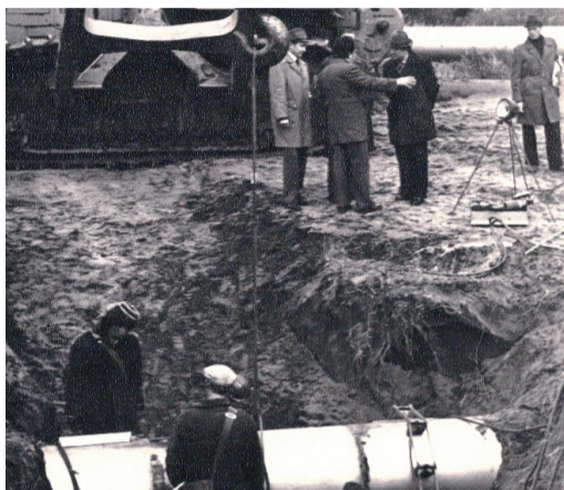
Устранение аварии. Фроловское ЛПУМГ, 70-е годы
