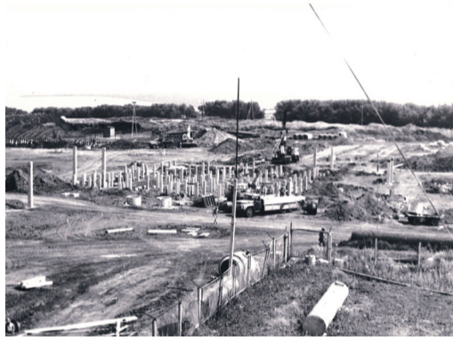
Начало строительства КС Антиповка, 1971 год
