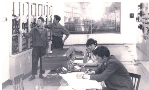
Главный щит управления Палласовское ЛПУМГ
