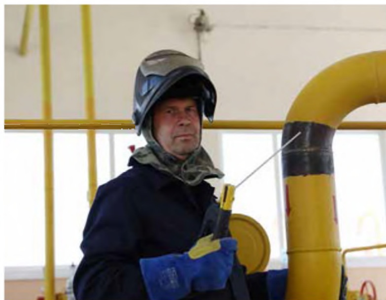
Ремонт технологических трубопроводов КС «Волгоградская» выполняет сварщик 6 разряда Валерий Ковалев
