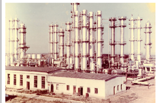
Установка сероочистки. Журновское РУМГ
