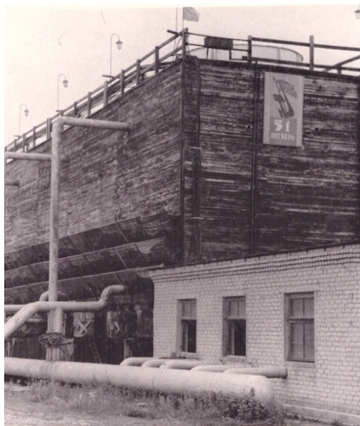
Градирня компрессорной станции Логовского РУМГ. 1968 г.
