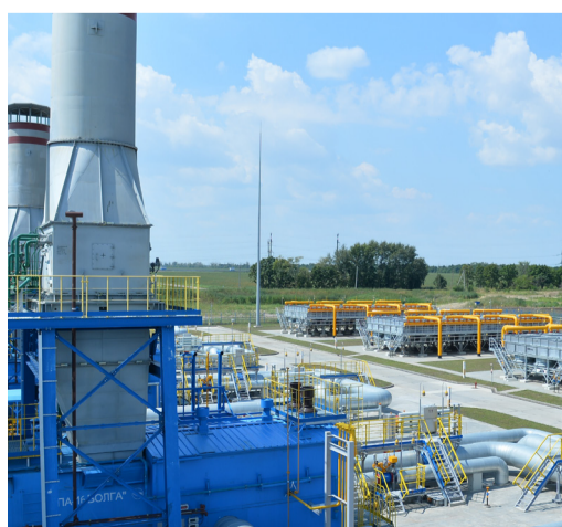
КС Бубновка после реконструкции
