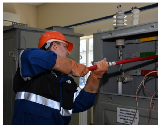
Конкурс монтеров по защите от коррозии
