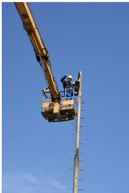
Энергетики должны уметь работать на высоте
