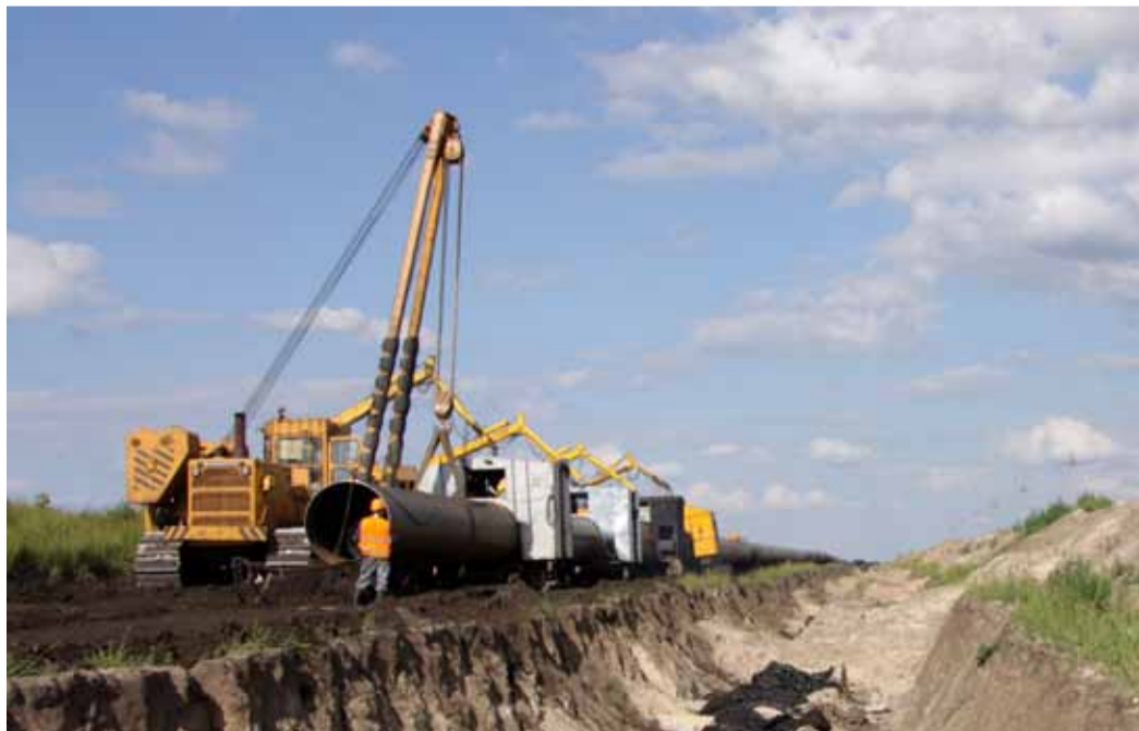
Капитальный ремонт МГ Уренгой-Новопсков в зоне ответственности Бубновского ЛПУМГ
