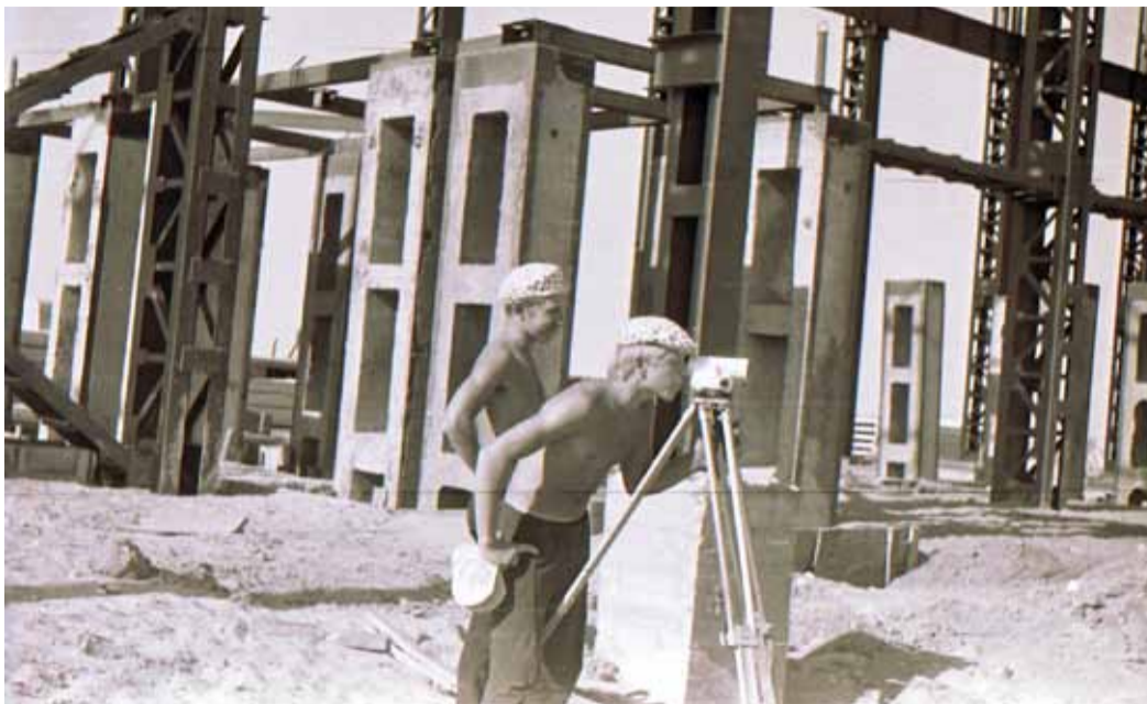
Строительство КЦ-1 КС "Антиповка"
