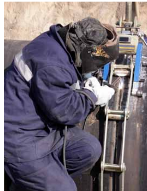
Сварочные работы на МГ Уренгой-Новопсков
