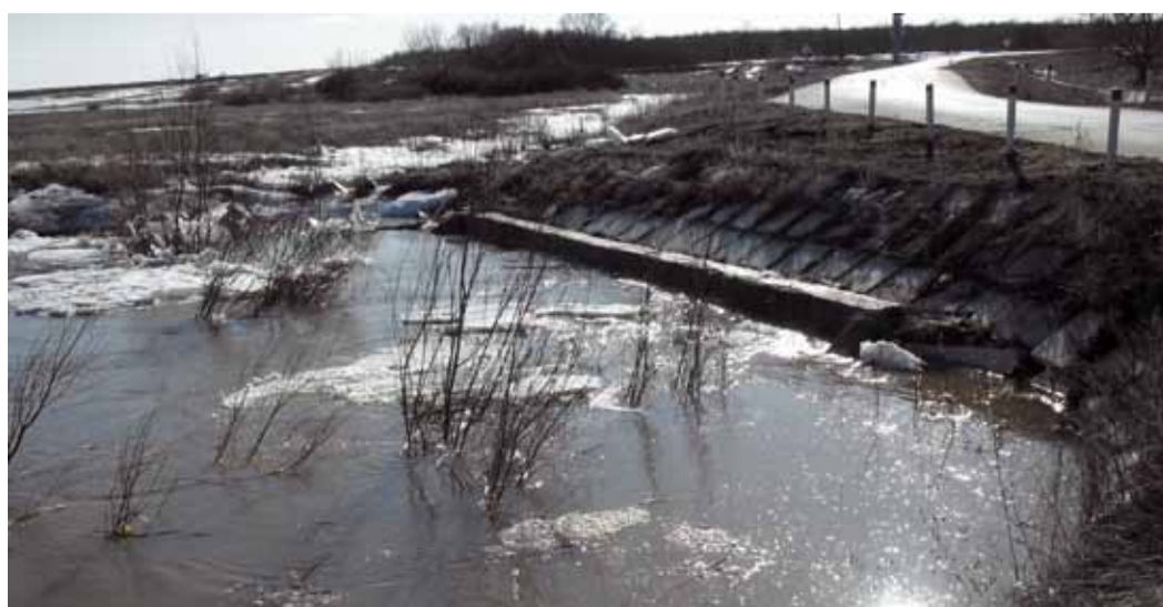
Переход МГ через подъездную дорогу к Ольховскому ЛПУМГ затоплен
