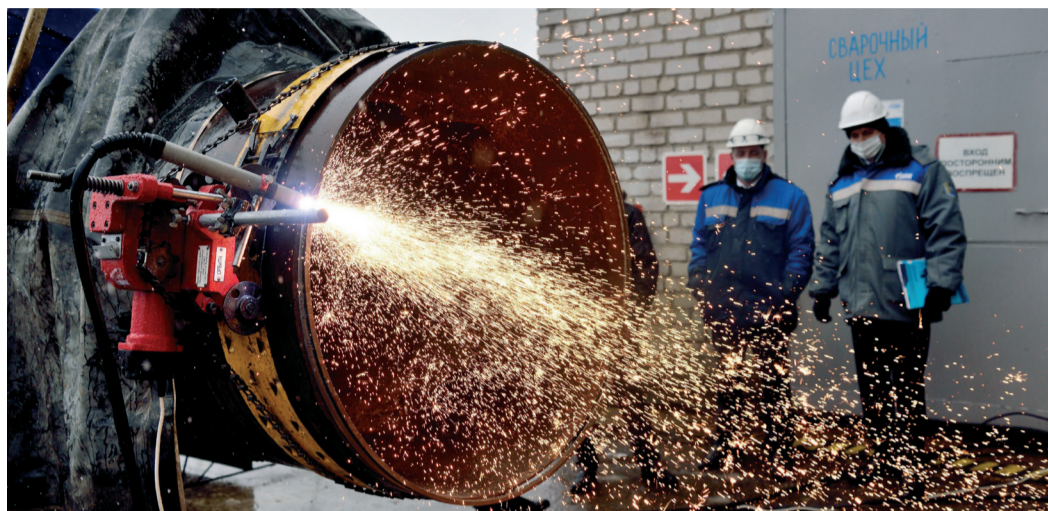
Демонстрация работы установки воздушно-плазменной резки
