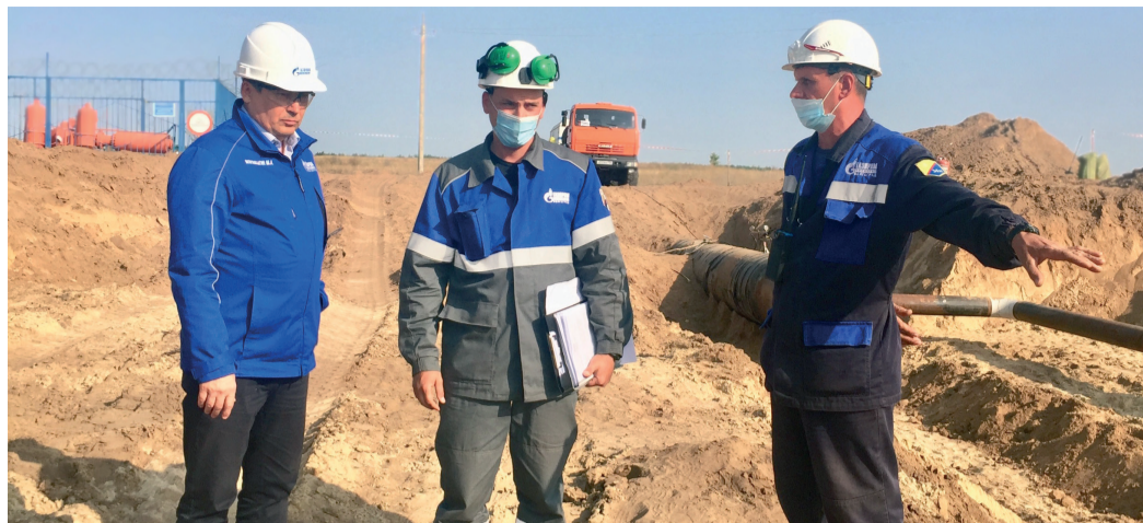
Подготовка к проведению ВТД, врезка временных камер запуска и приема очистных устройств на МГ "Оренбург-Новосков" на участке 936-942 км, переход через реку Дон. Генеральный директор Общества Юрий Марамыгин (слева), Иван Луговой (в центре) и Игорь Карпухин Фроловское ЛПУМГ
