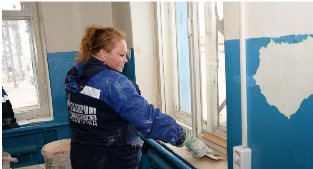
Проведение ремонтных работ хозспособом в подсобном помещении УАВР
