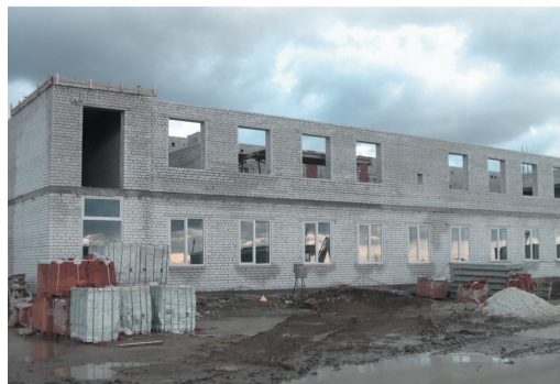
Строительство АБК Коробковской промплощадки
