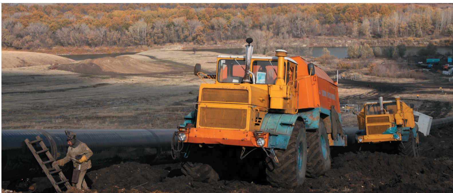
Реконструкция газопровода САЦ-III на переходе через реку Хопер, 2010 год
