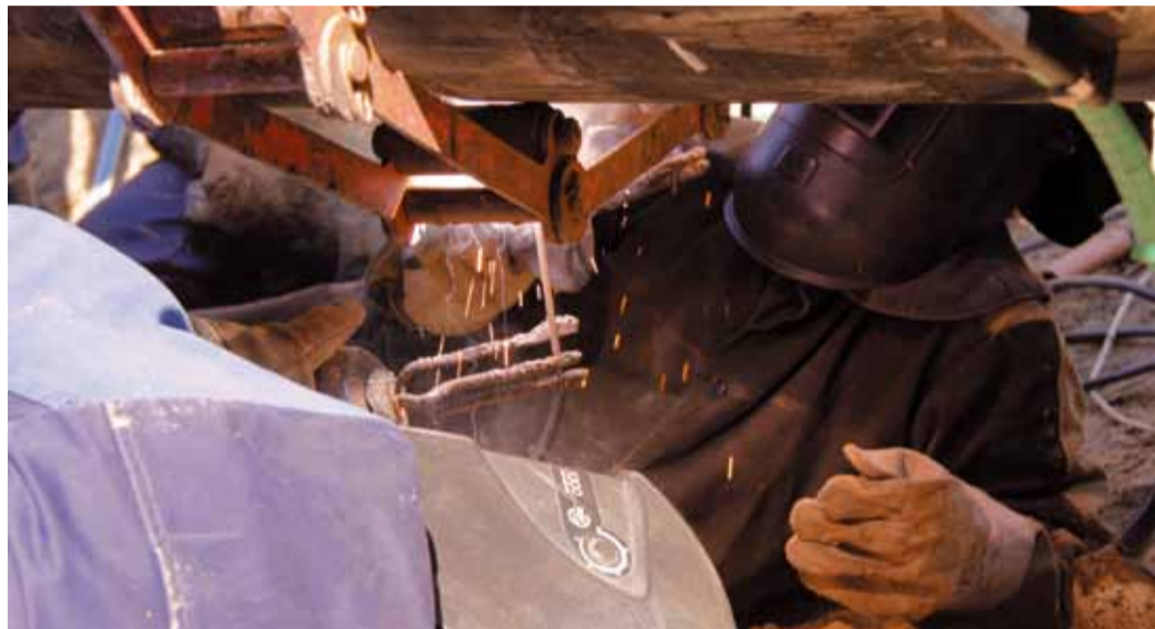
Сварочные работы на газопроводе "Уренгой - Новопсков"
