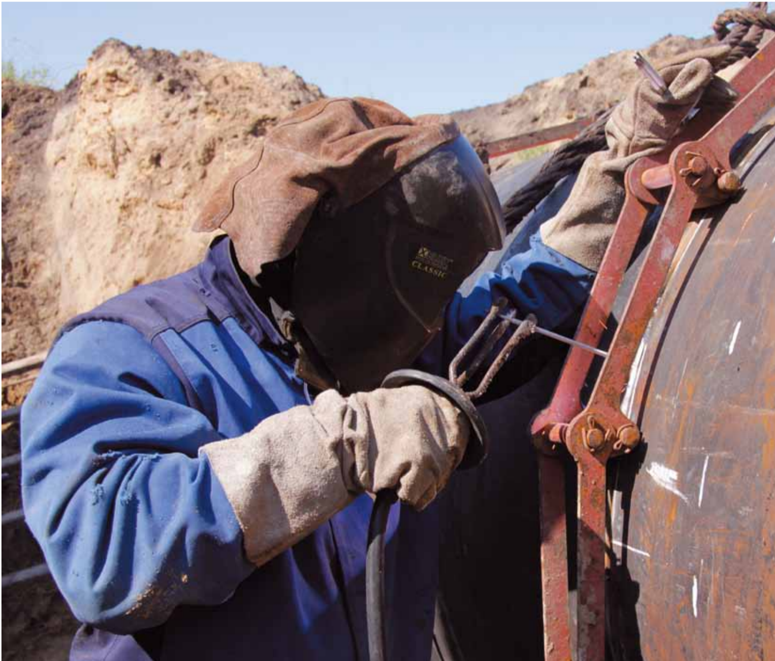
Сварочные работы на участке АВП-2 УАВР
