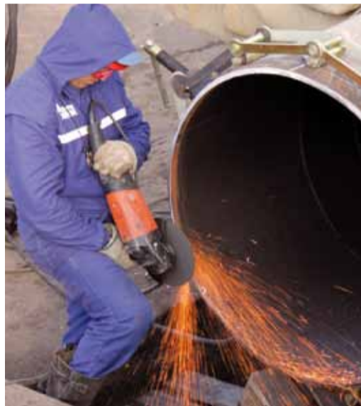
Подготовка среза к сварочным работам
