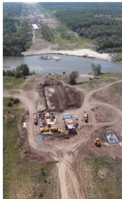
Реконструкция перехода газопровода САЦ IV-2 через реку Медведица
