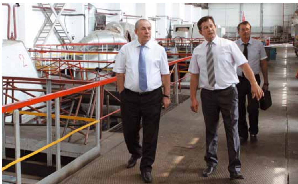
В компрессорном цехе Усть-Бузулукского ЛПУМГ
