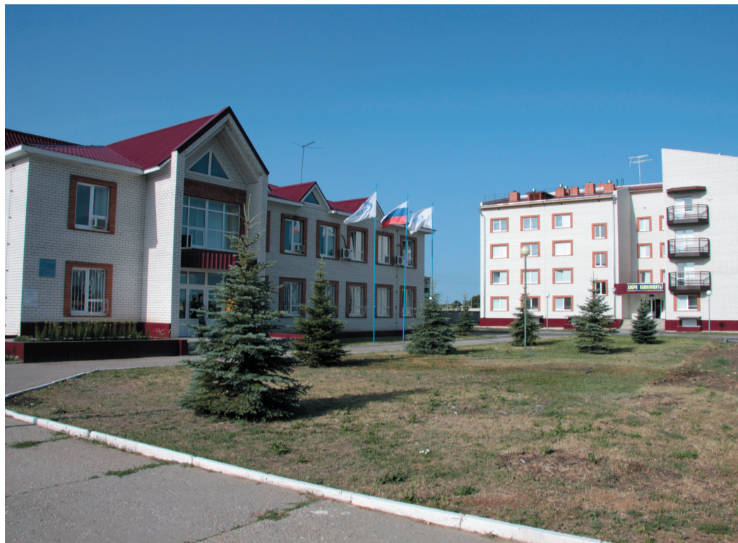
Учебно-производственный центр. Учебный корпус (слева), общежитие
